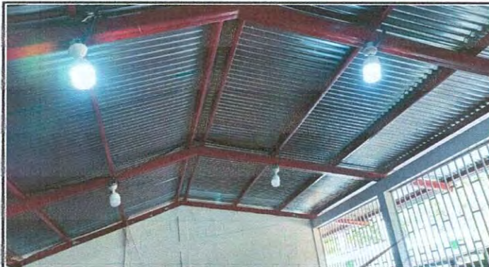
Foto 8: Reparación de sistema eléctrico
