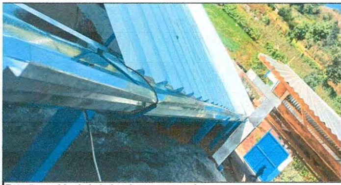
Foto 5: cambio de bajadas de agua y canales
