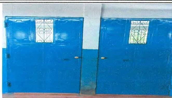
Foto 2: Pintura de puertas, por deterioro. PUERTAS DE METAL
