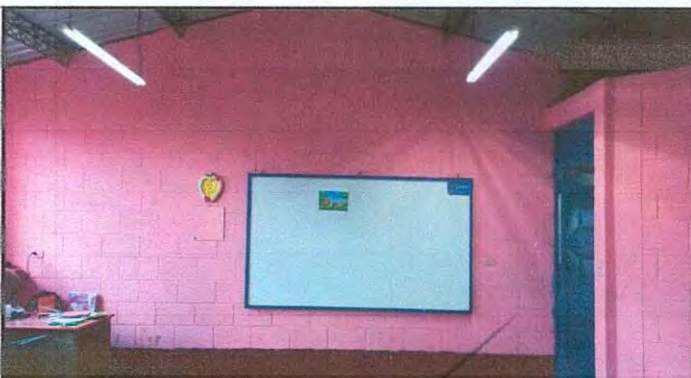
Foto 10: Pintura en muros interiores
