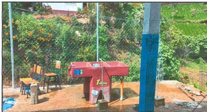
Foto 9: Sustitución de pila
