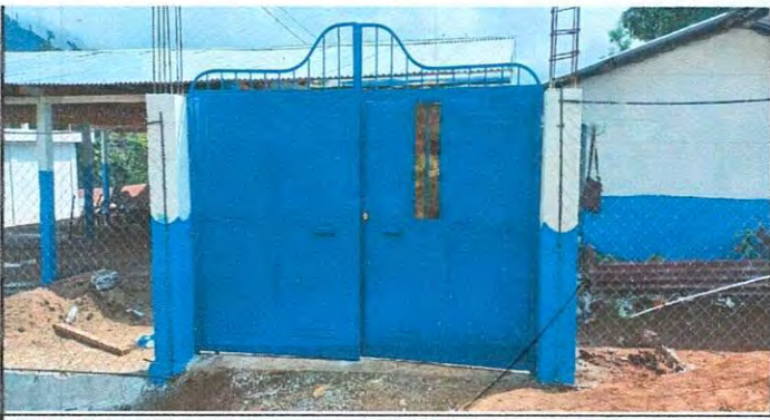
Foto 12: Sustitucion de portón de metal.
