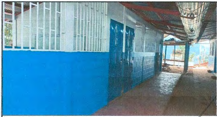
Foto 11: Pintura de muros exteriores
