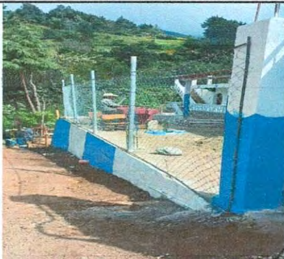
Foto 7: Reparacion de tubo y malla galvanizada
