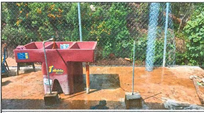
Foto 6: cambio de tuberia principal de chorro de pila
