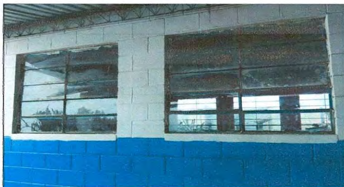
Foto 3: cambio de vidrios en ventanales.
